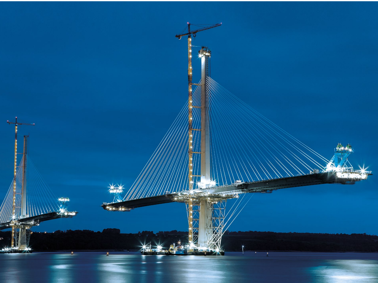
Stahlbetonpylon mit Schrägseilverspannung und abgehängter Fahrbahn während der Bauphase.
