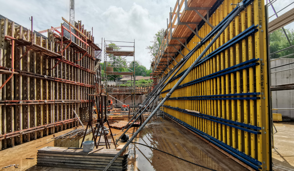
Blick auf die Baustelle. © ACMS Architekten GmbH, Wuppertal
