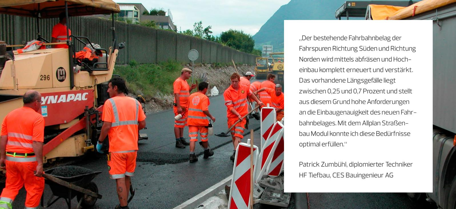
„Der bestehende Fahrbahnbelag der Fahrspuren Richtung Süden und Richtung Norden wird mittels abräumen und Hoch-einbau komplett erneuert und verstärkt. Das vorhandene Längsgefälle liegt zwischen 0,25 und 0,7 Prozent und stellt aus diesem Grund hohe Anforderungen an die Einbaugenauigkeit des neuen Fahrbahnbelages. Mit dem Allplan Straßenbau Modul konnte ich diese Bedürfnisse optimal erfüllen.“
